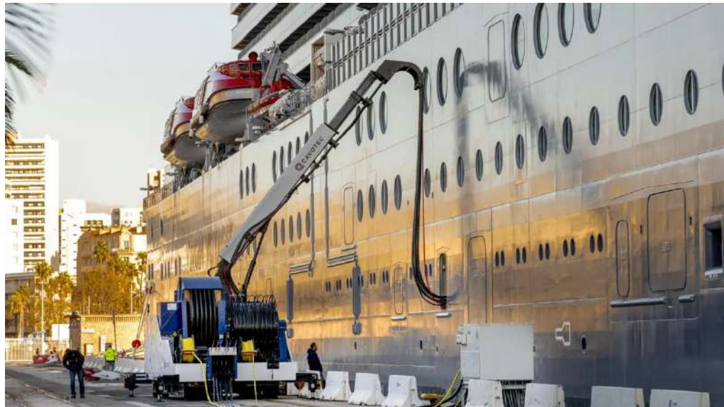
Opération de connexion électrique / Source : MTPM
